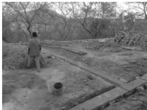
Základy pro novou budovu
